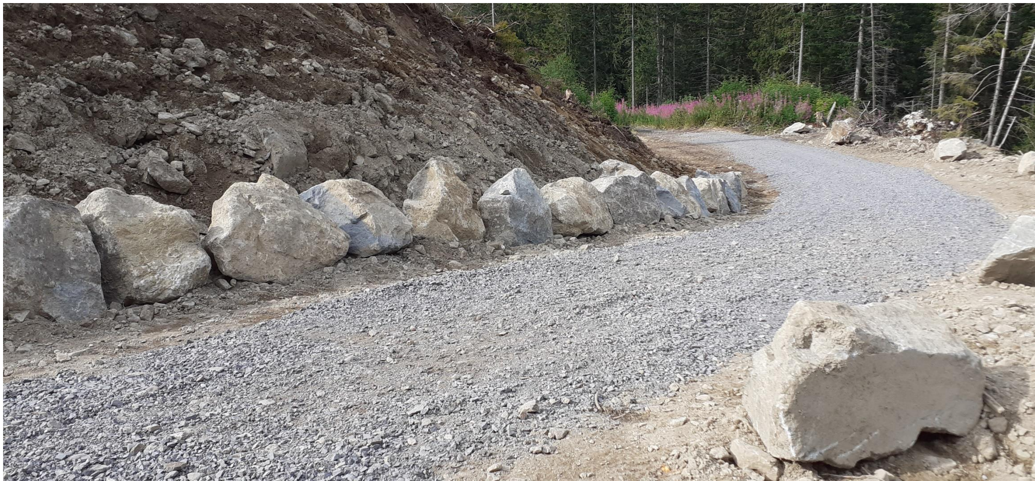
Opravený úsek cesty – Račková dolina
