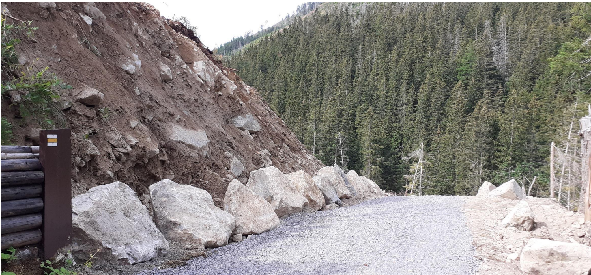
Opravený úsek cesty – Račková dolina
