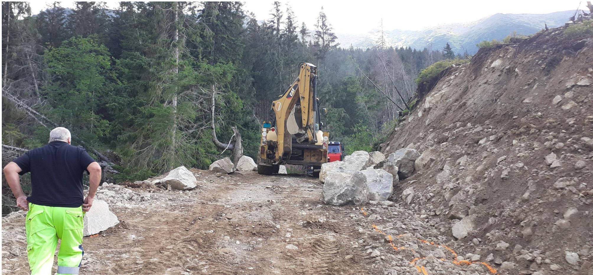
Oprava poškodeného úseku cesty – Račková dolina
