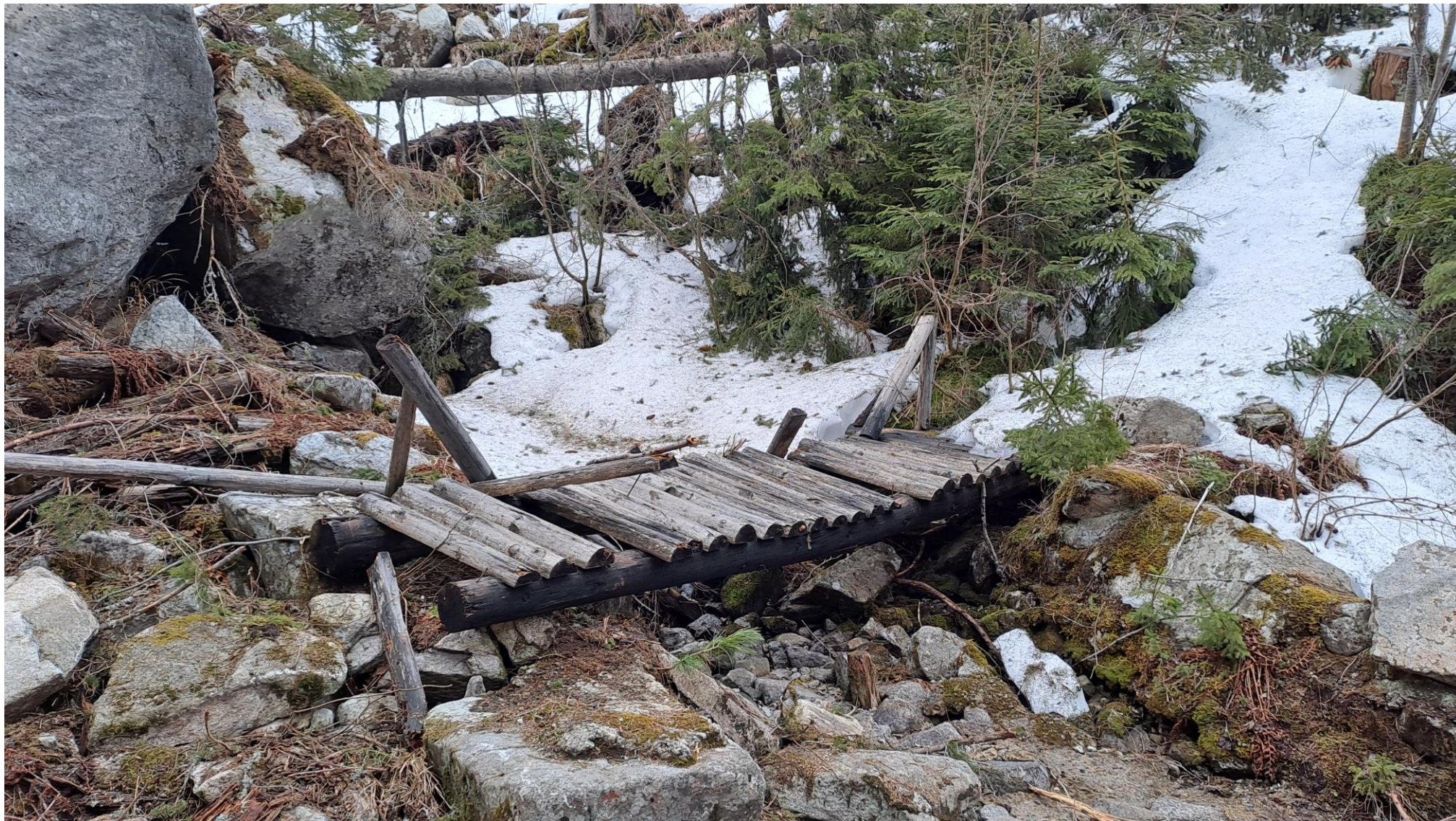
Most Prostredné – pred rekonštrukciou
