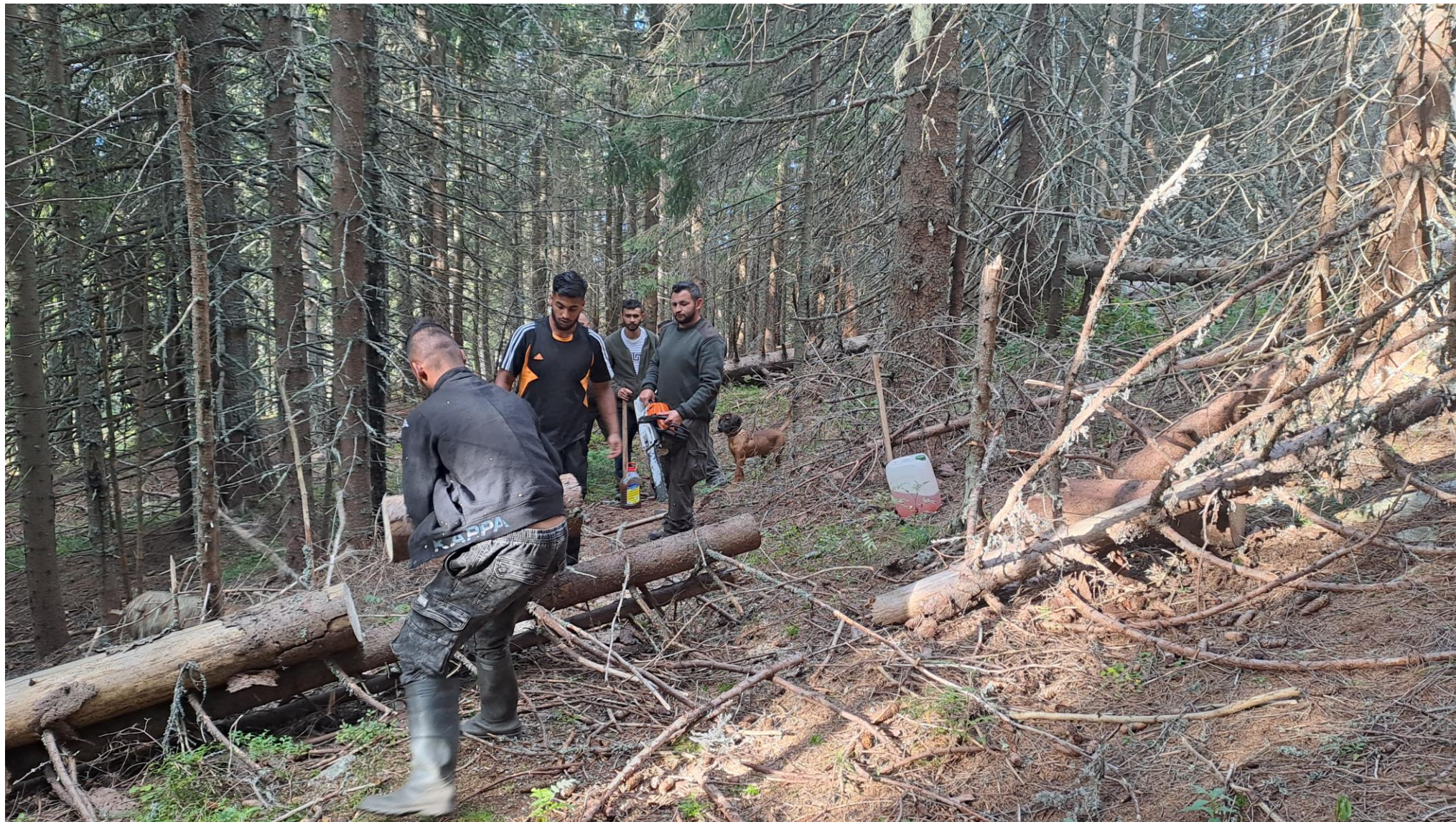
Práce pri rekonštrukcii obvodového chodníka Páterské - Krivul'a
