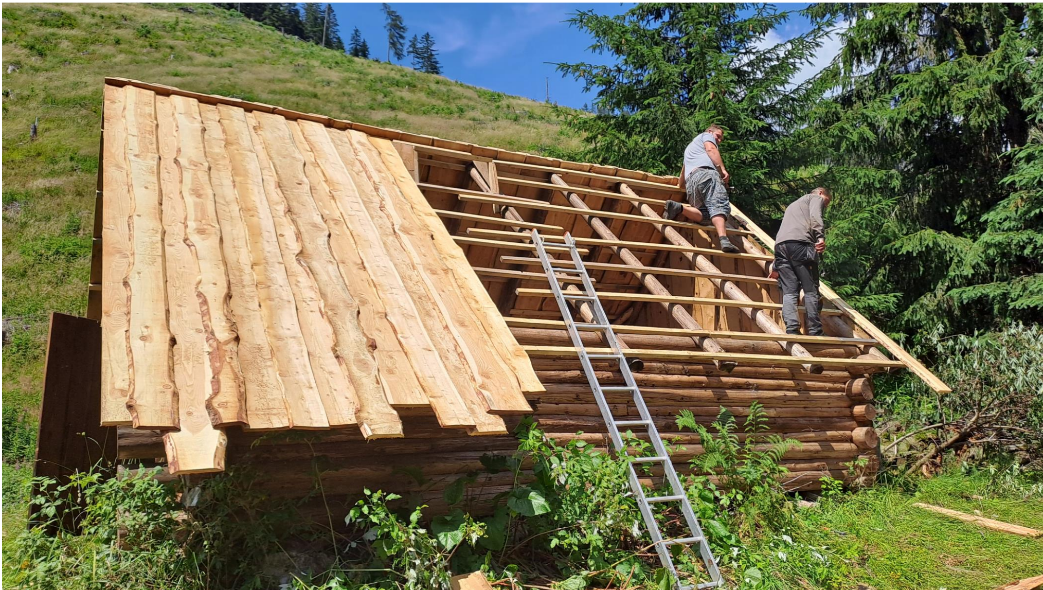
Výmena strešnej krytiny – koliba Sigot'
