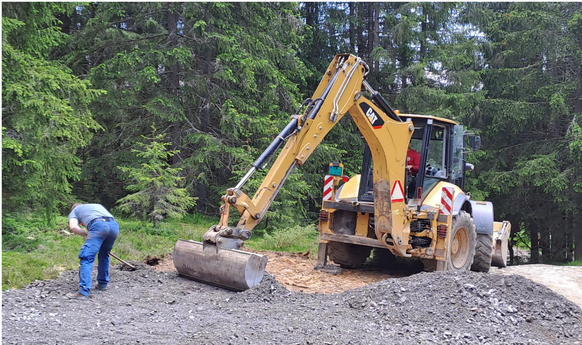
Úprava plochy pre platené parkovisko Hrdovo
