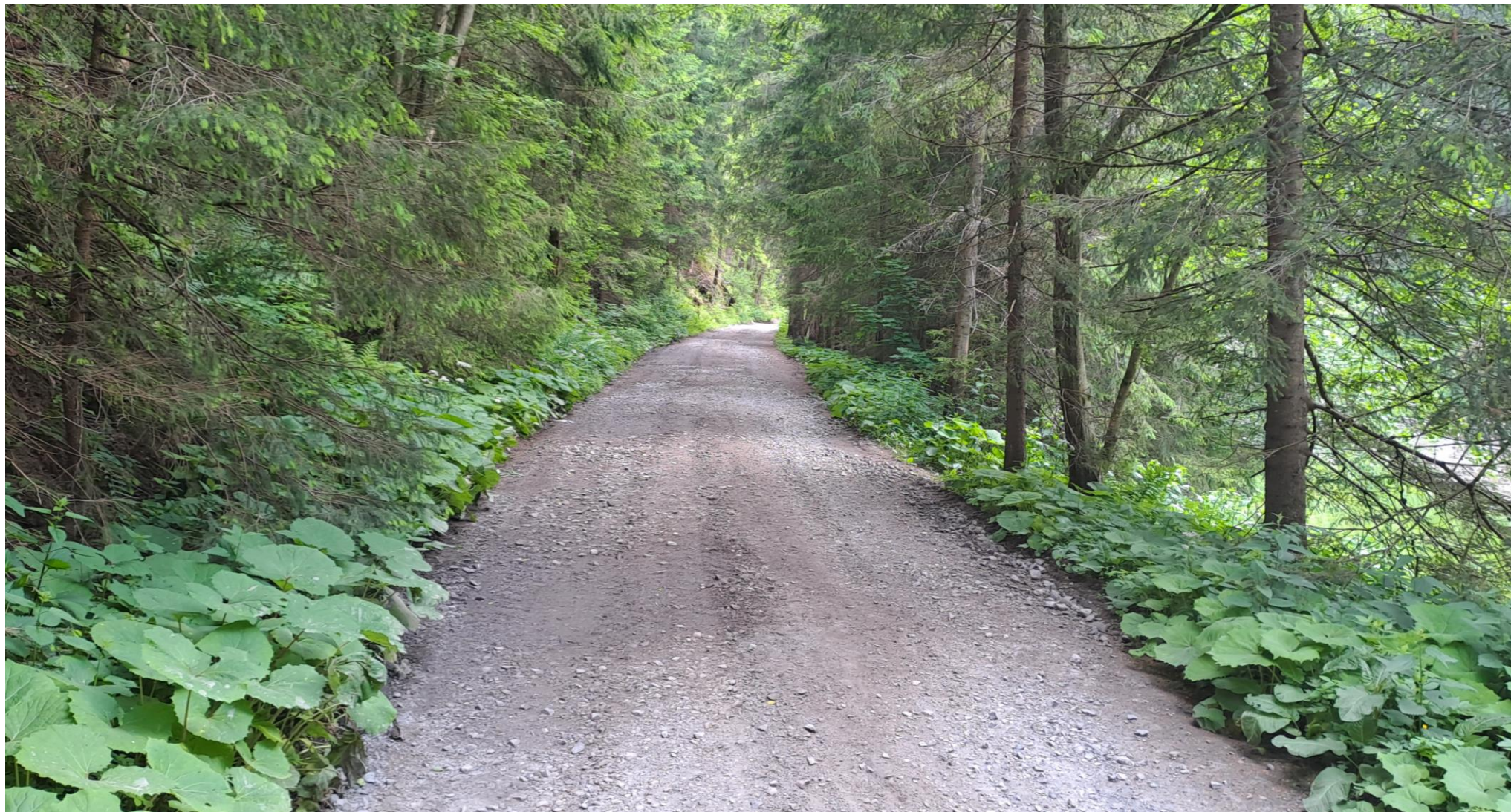
Rekonštruovaný úsek lesnej cesty – Račková dolina
