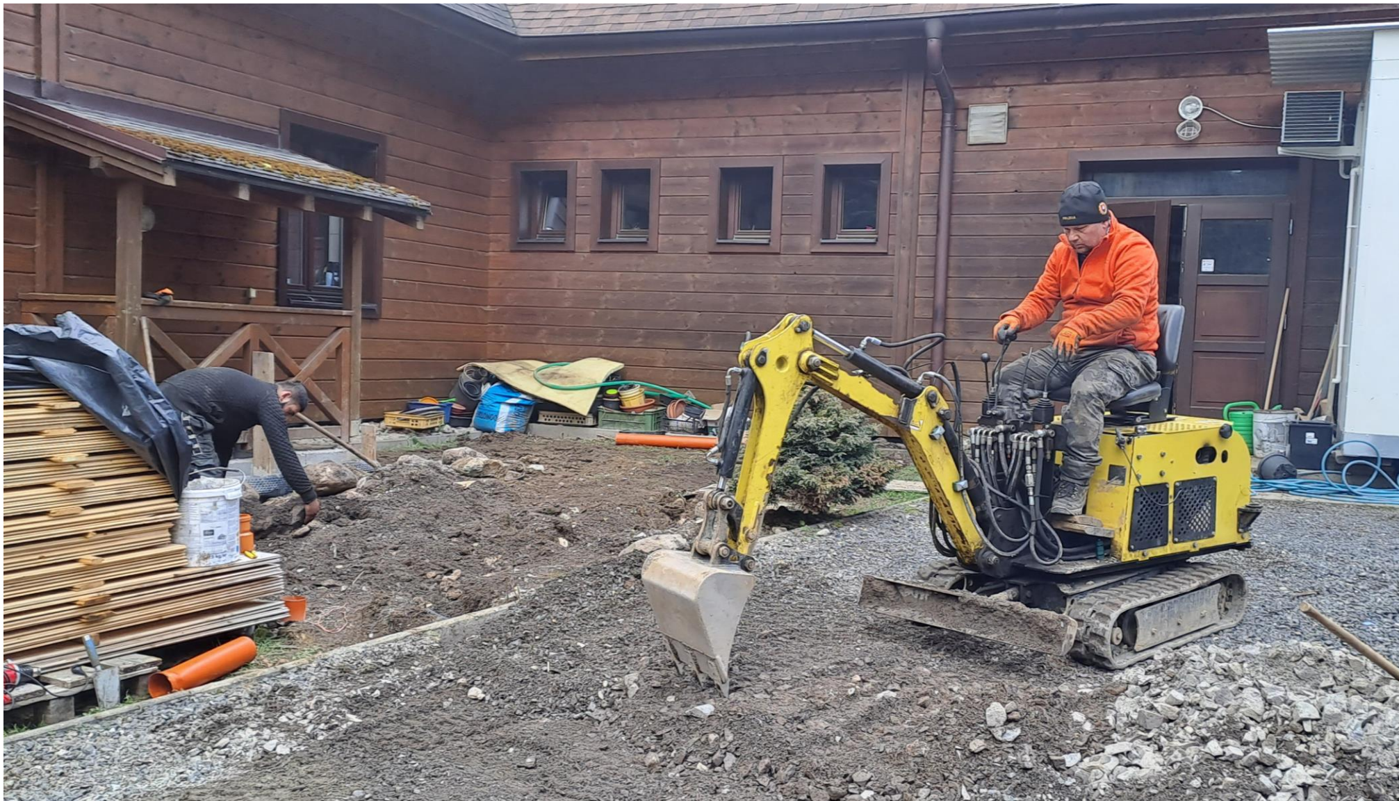
Práce pri oprave pivničného múru Penziónu Sileo
