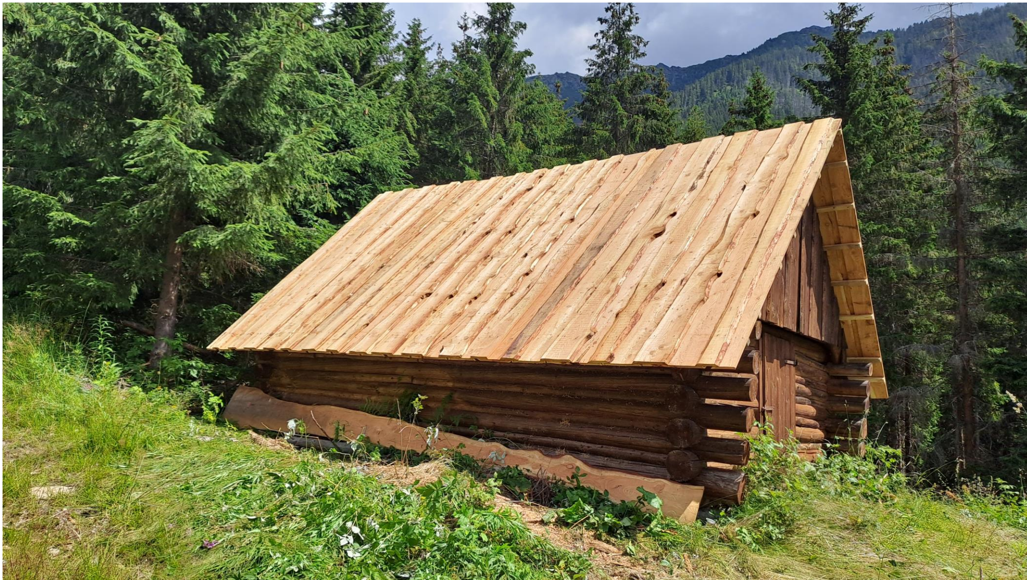
Rekonštruovaná koliba Sigot'
