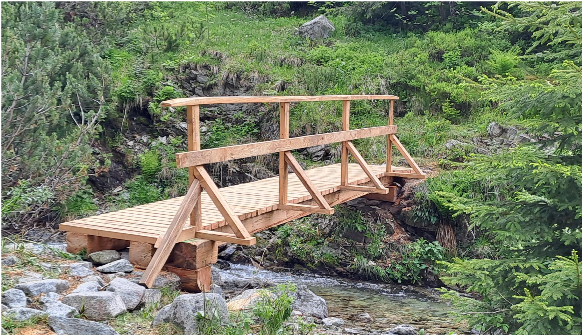
Most Pod Klinom po rekonštrukcii
