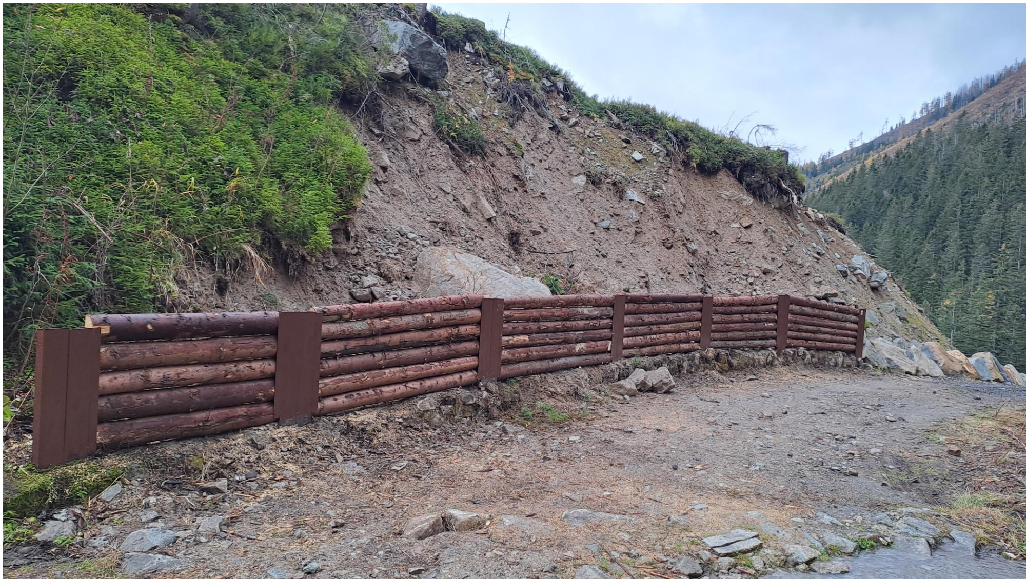
Rekonštruovaný oporný múr - Prostredné
